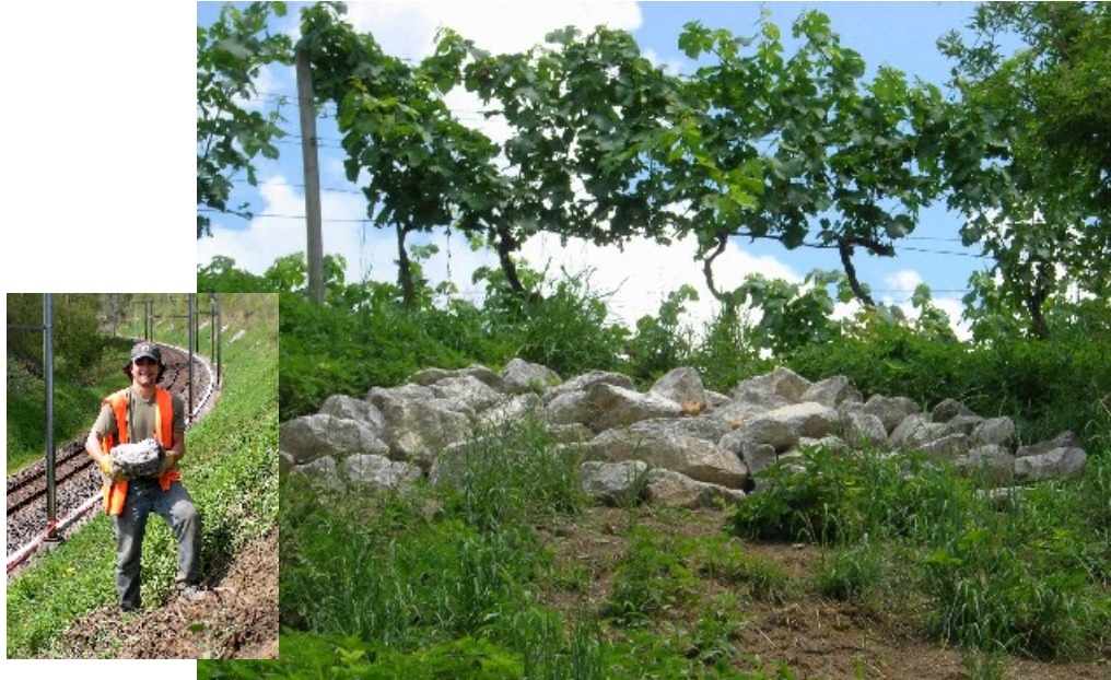
Bau von Steinlinsen für die Schlingnatter entlang des Bahndammes in Ossingen.
