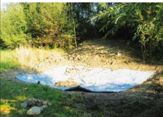
Der Folienteich wird mit Lehm ausgekleidet
