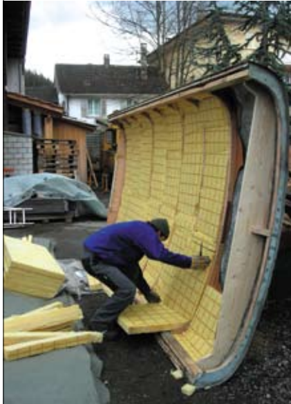
Isolation des Dachs
