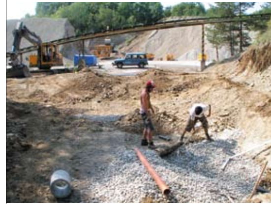
Anlage der Sickerpackung für die temporäre Trockenlegung des Gewässers
